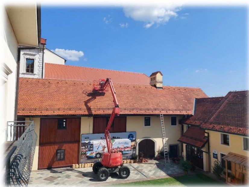
Pregled ostrešja celotne knjižnice in zamenjava poškodovanih strešnikov (foto: Alfonz Zavrnik).
