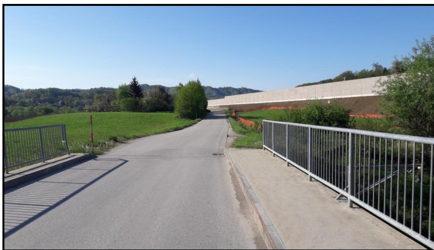
Slika 1: Most čez Rogatnico – začetek predvidenega hodnika za pešce
